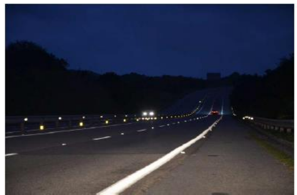
Figura 6.7 Via Lagos - Sinalização horizontal e sinalização refletiva
