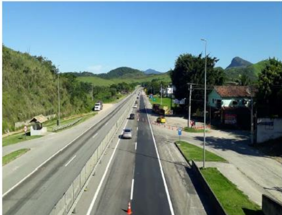
Figura 6.8 Via Lagos - Obra de recuperação de pavimento
