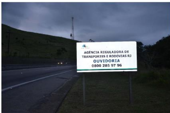
Figura 6.9 Via Lagos - Sinalização vertical
