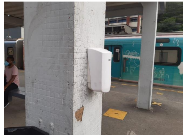
Figura 5.34 SuperVia – Estação Belford Roxo – 20/12/2020
