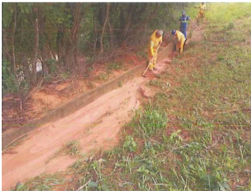
Figura 6.14 Rota 116 – Limpeza da canaleta. (Fonte: Relatório Técnico Operacional)
