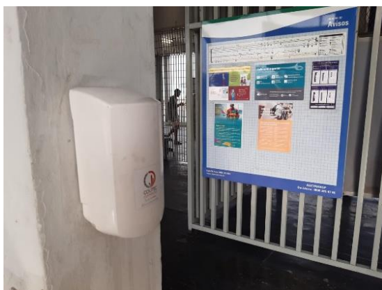
Figura 5.39 SuperVia – Estação Pavuna – 29/12/2020
