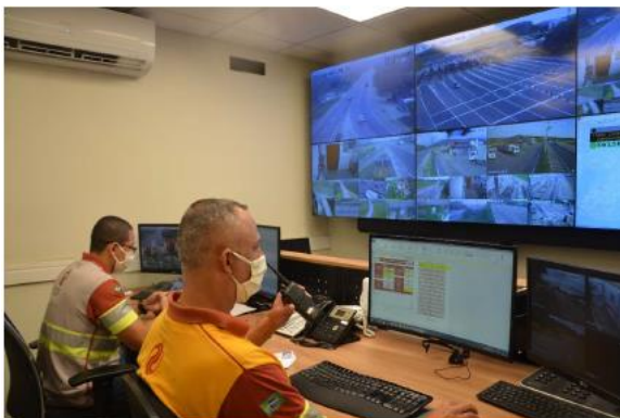
Figura 6.4 Via Lagos - Interior do CCO
