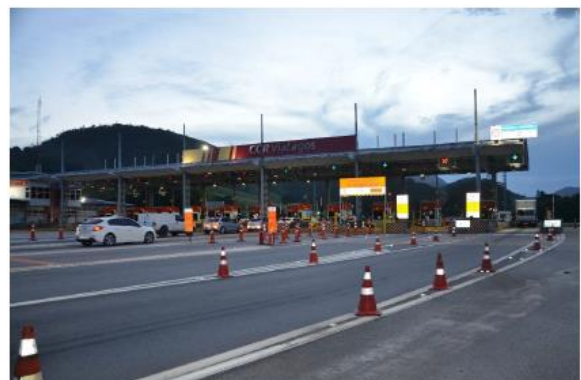
Figura 6.13 Via Lagos - Praça de pedágio
