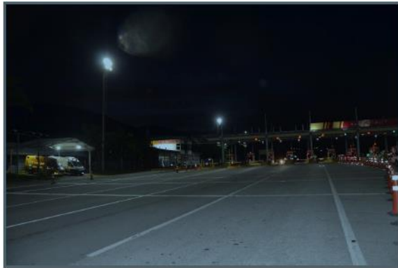
Figura 6.2 Via Lagos - Praça de Pedagio
