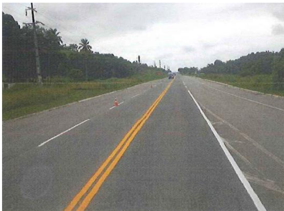
Figura 6.15 Rota 116 – Repintura de sinalização horizontal. (Fonte: Relatório Técnico Operacional)
